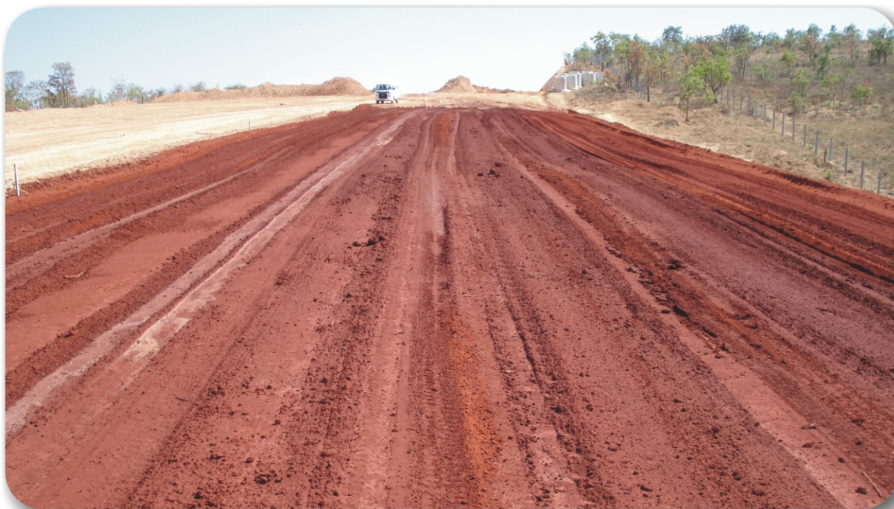
Fase de construção.
