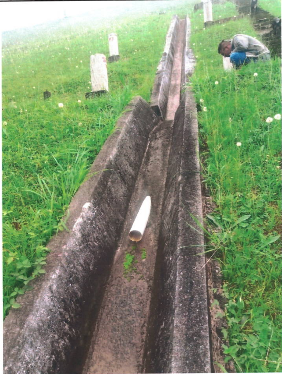
Figura 15: Canaleta no talude jusante
