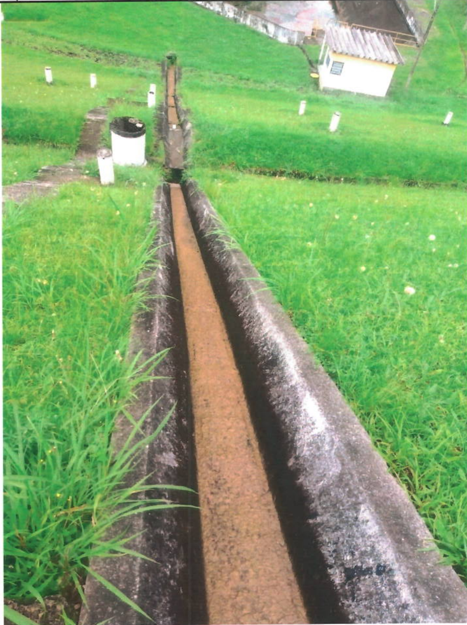
Figura 16: Canaleta de drenagem
