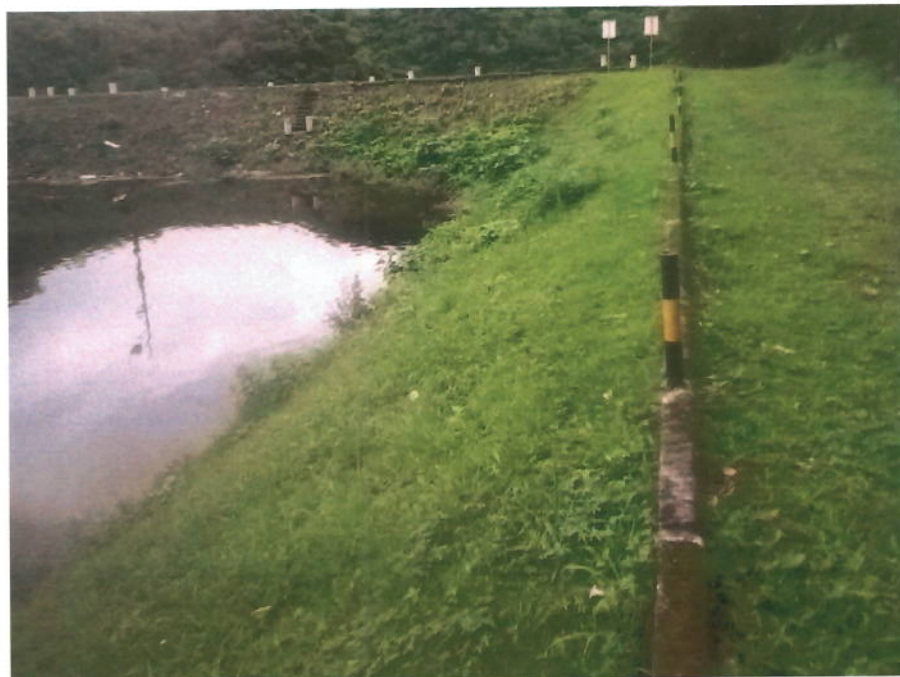
Figura 22: Ombreira direita a montante
