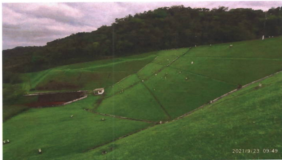
Figura 14: Vista do talude de jusante
