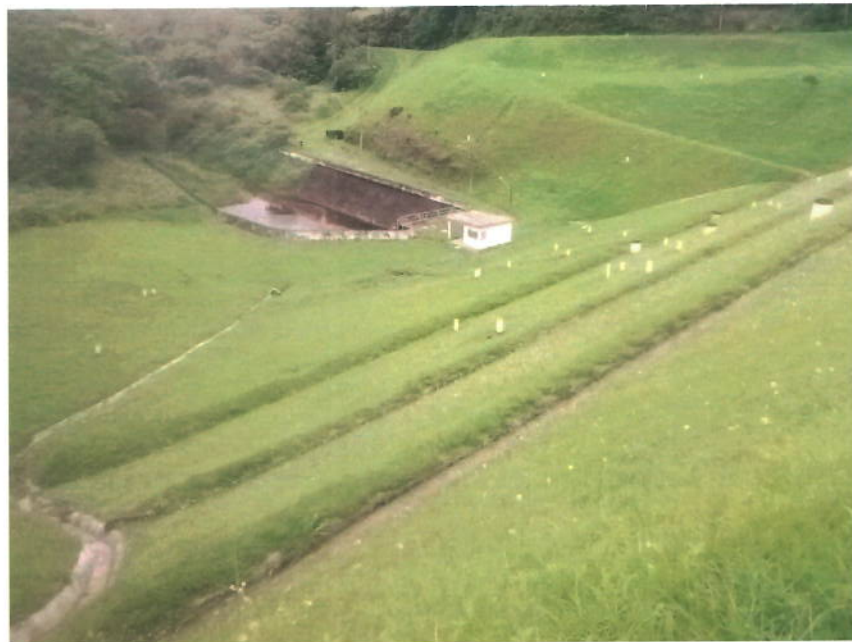
Figura 12: Vista geral do talude de jusante
