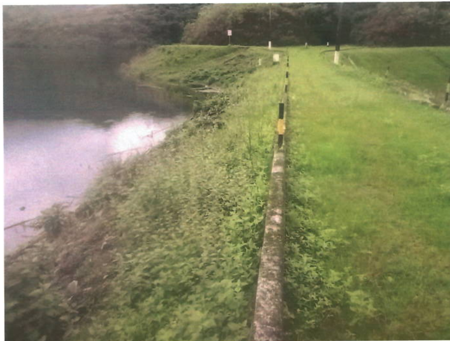
Figura 11: Vista geral de montante
