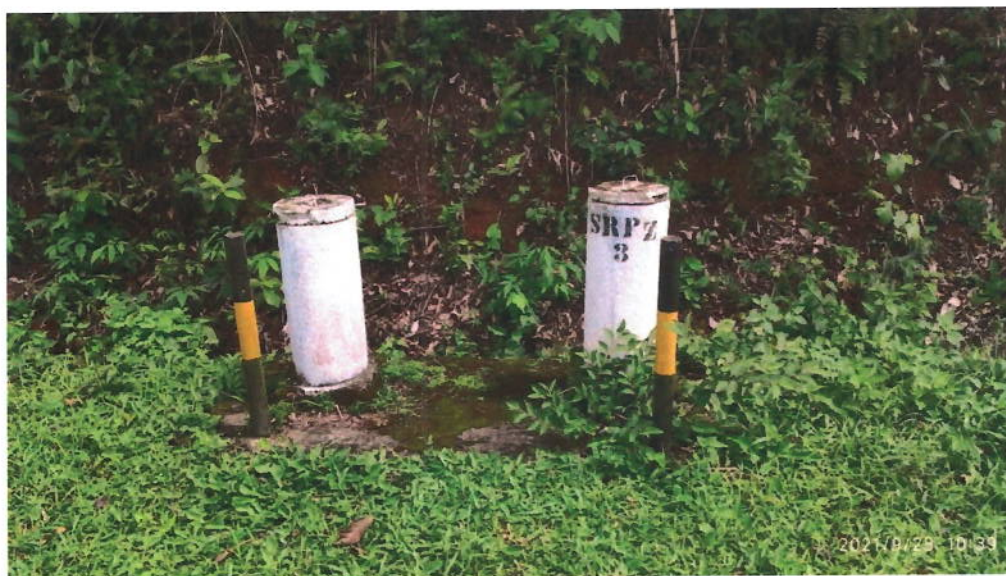
Figura 18: Piezômetros no talude de jusante – setembro 2021
