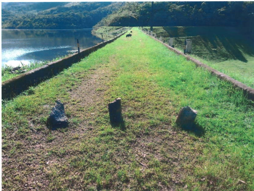
Figura 7 Vista geral da crista da Barragem Saracuruna
