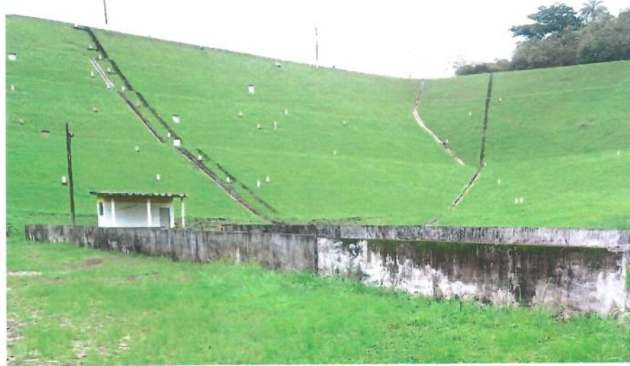
Figura 13: Vista do talude de jusante e do pé da barragem
