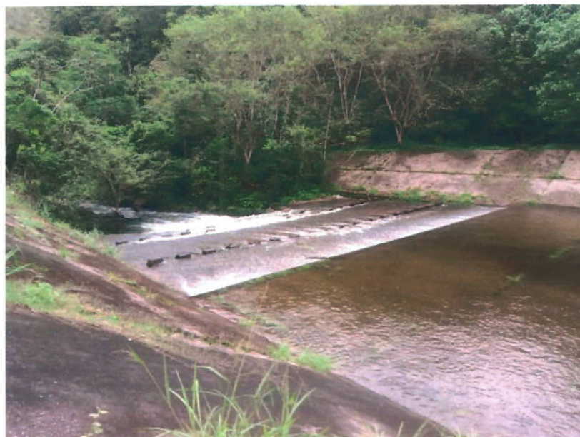
Figura 30: Vista geral do vertedouro com vegetação nos muros laterais
