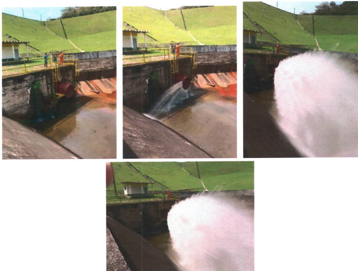
Figura 36 Teste de abertura do descarregador de fundo.
