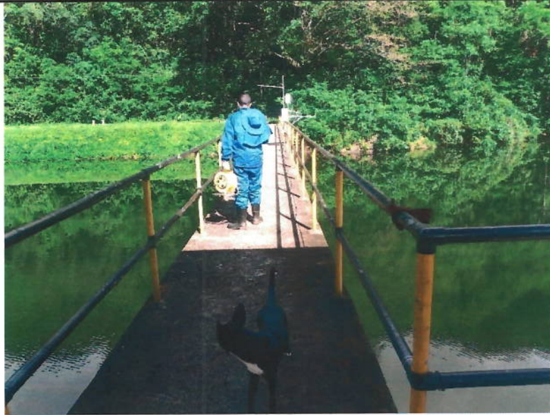
Figura 32: Vista geral da torre de tomada de água, passarela de acesso
