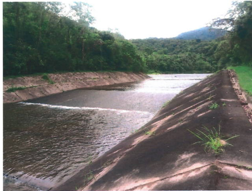
Figura 27: Vista geral do vertedouro
