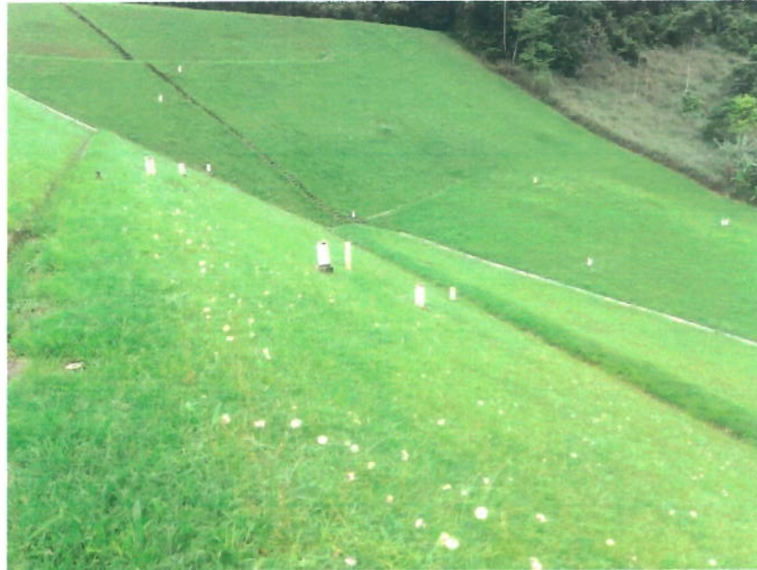
Figura 19: Ombreira esquerda a jusante
