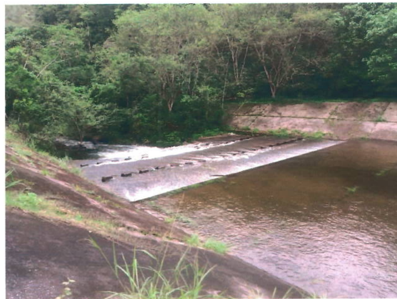
Figura 28: Vista geral do vertedouro
